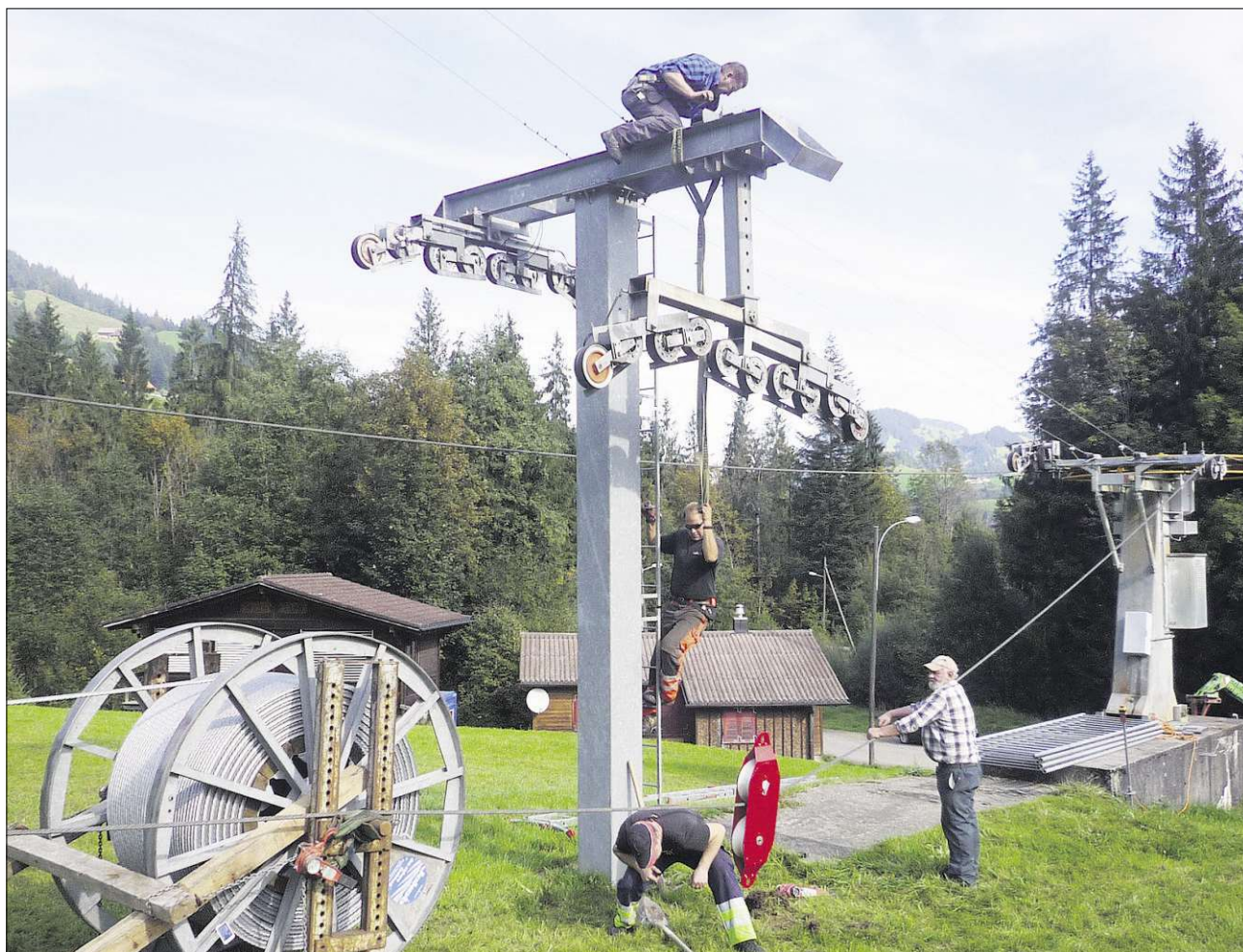
Das neue Förderseil wird von der Firma Paul Reber aus Schüpheim eingezogen. [Bild zVg]
